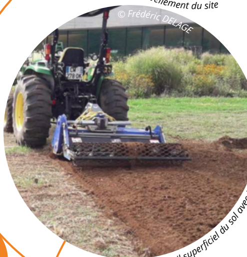
Terrassement et nivellement du site
